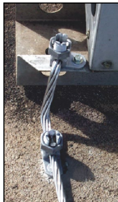
Conexão em estruturas metálicas
