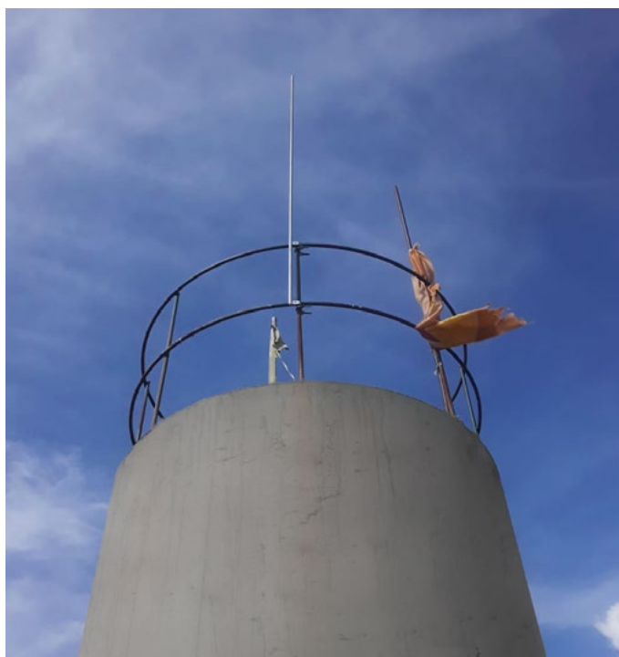
Exemplo de instalação do Termocaptor para guarda corpo.
