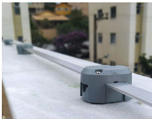
FIXATEL® com barra chata de alumínio Tel 776 na captação
