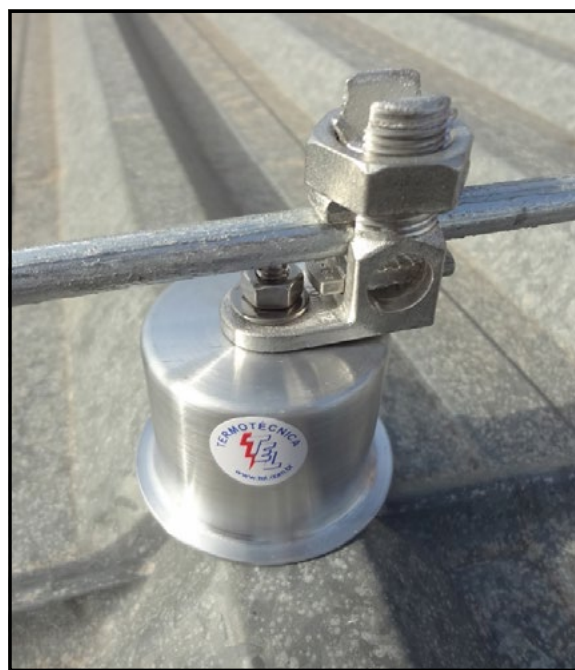
Equipotencialização de telhas metálicas
