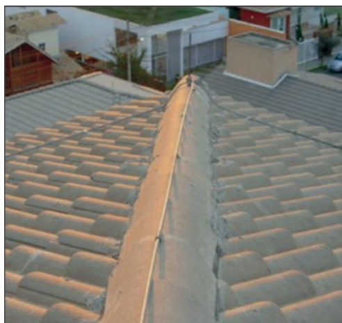
Utilização da Rebar na captação.
