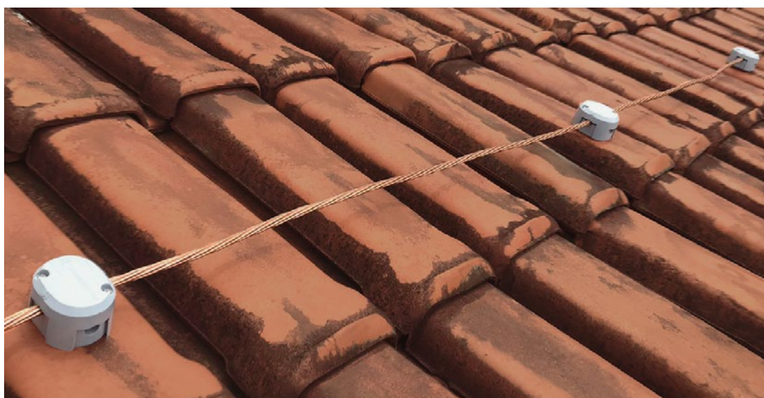
Aplicação do FIXATEL® em telha cerâmica com adesivo Tel 5904
