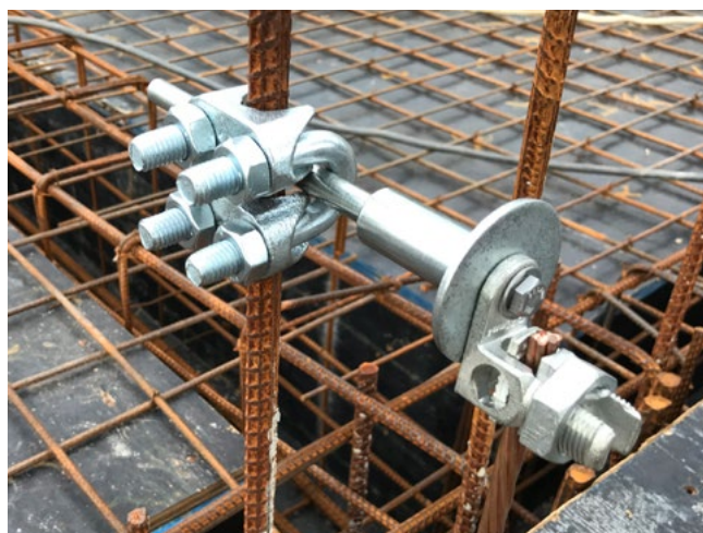
Aplicação do ATERRINSERT® LONG Tel 658 em equipotencialização com ferragem Ø 16mm
