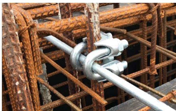
Aplicação do Conector Duplo-clips Tel 5458. Conexão entre Rebar e ferragem Ø 16mm
